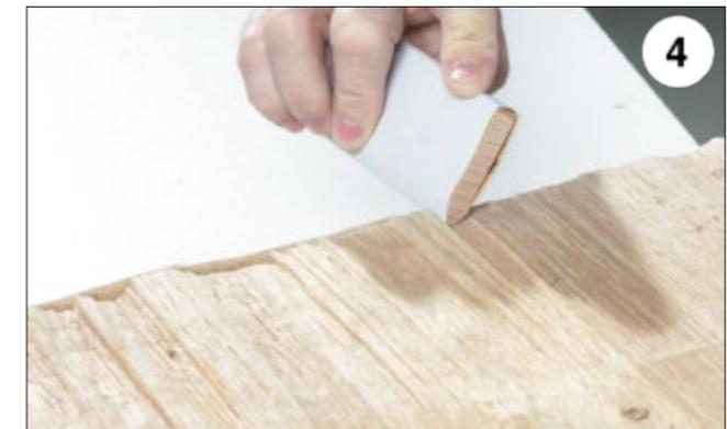
Enge Strukturverläufe müssen mit geeigneten Schleifpapierträgern nachgearbeitet werden.
