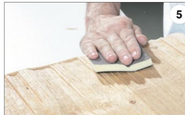
Kante anschließend mit Schleifschwamm (Körnung ca. 100) nacharbeiten. Dabei in Strukturaufrichtung über die Kante schleifen.
